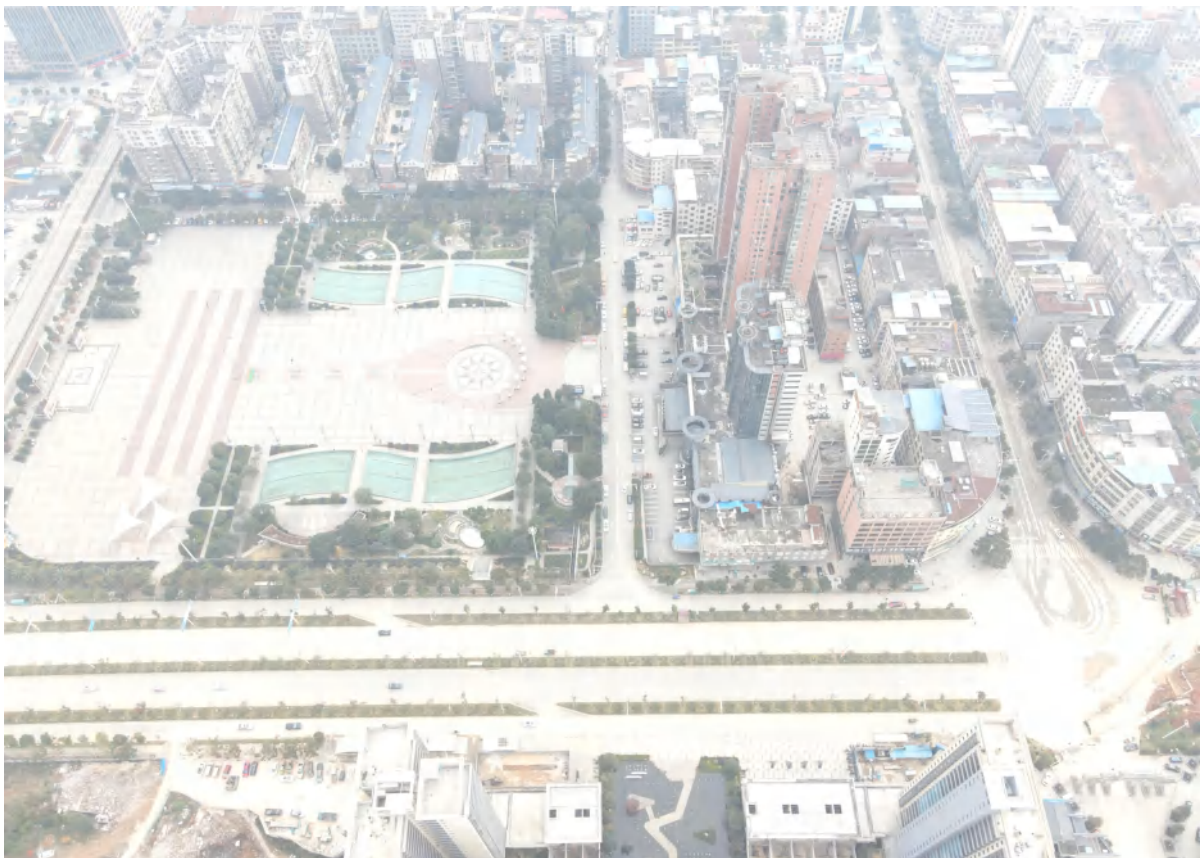
图 3.4.1-1 地块东面市政广场和南海明珠小区。
