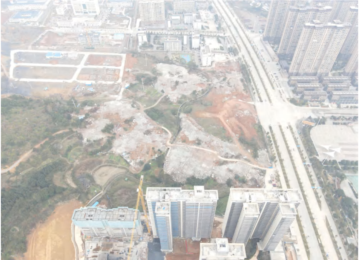
3.4.1-4 地块北面的三里村住宅区已经拆除
