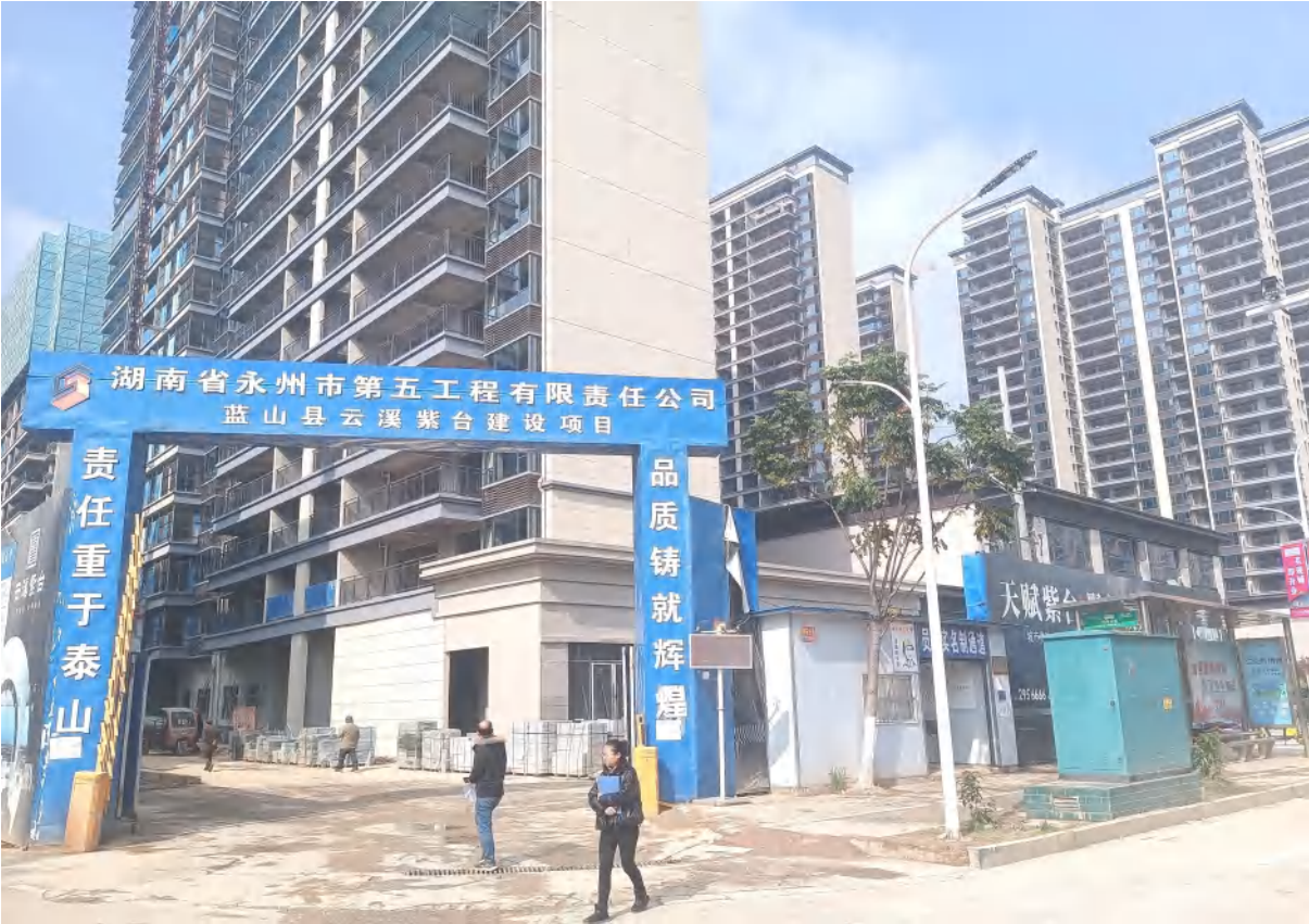
图 3.3.1-2 地块现状： 地块（云溪紫台）建设项目东南角入口。
