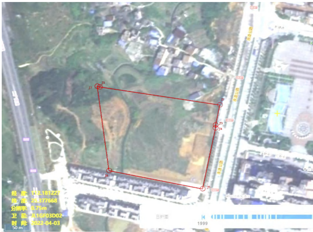
图 3.3.2-4 地块历史卫星图（2022 年 4 月 3 日）：地块内云溪紫台项目开始动工。
