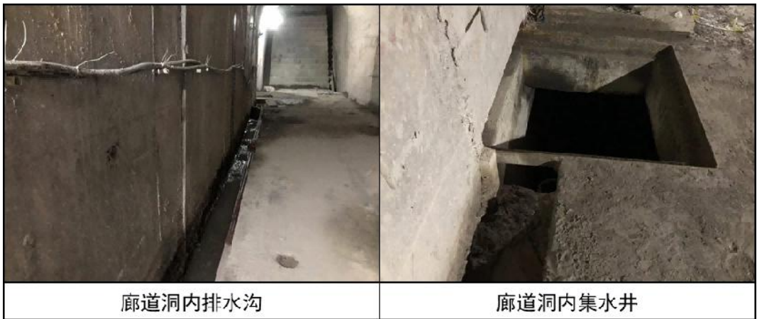
图 4.2-16 洞室排水处理措施现场照片
