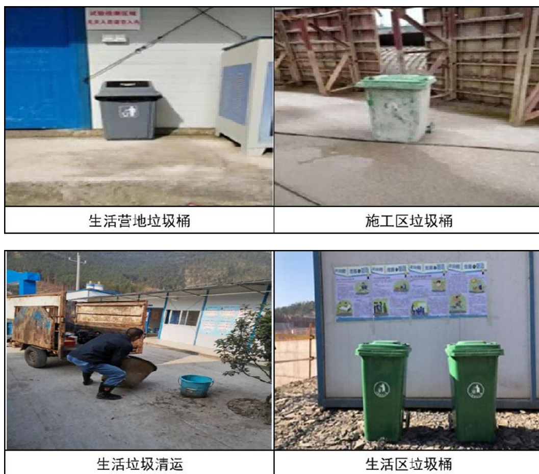
图 4.2-22 生活垃圾处理现场照片
