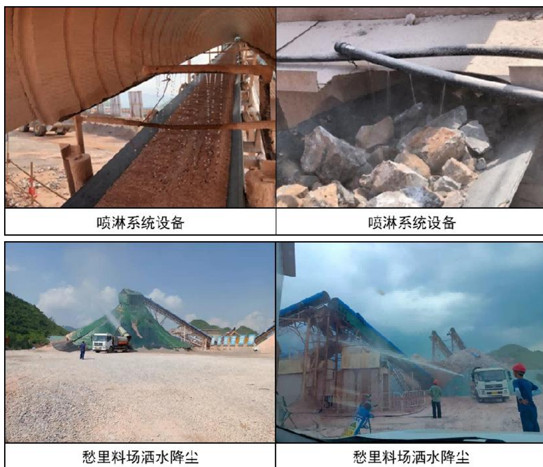
图 4.2-20 砂石料加工系统粉尘控制现场照片
