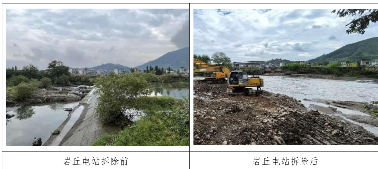
图 4.2-3 滚水坝和水电站拆除前后照片
