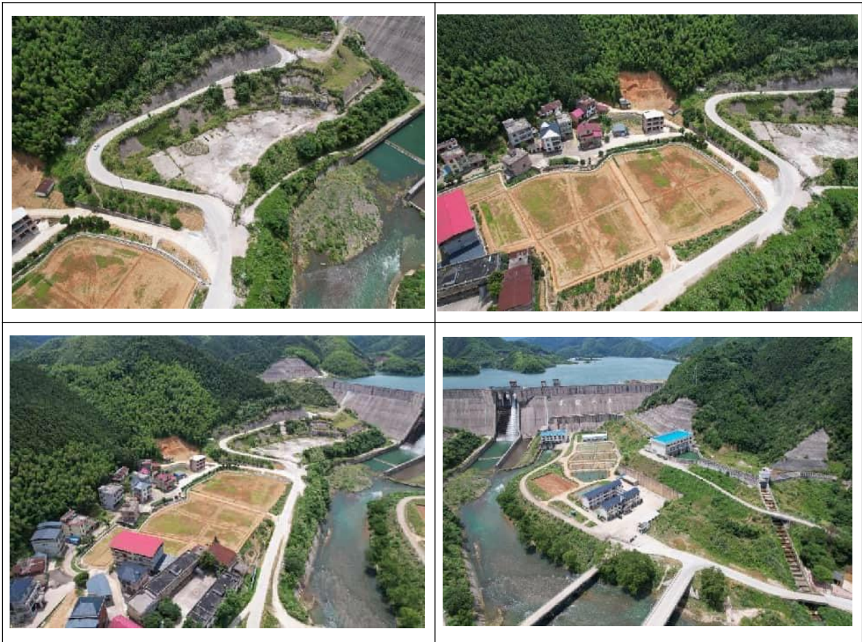
图 4.2-11 施工临建区绿化情况现场照片
