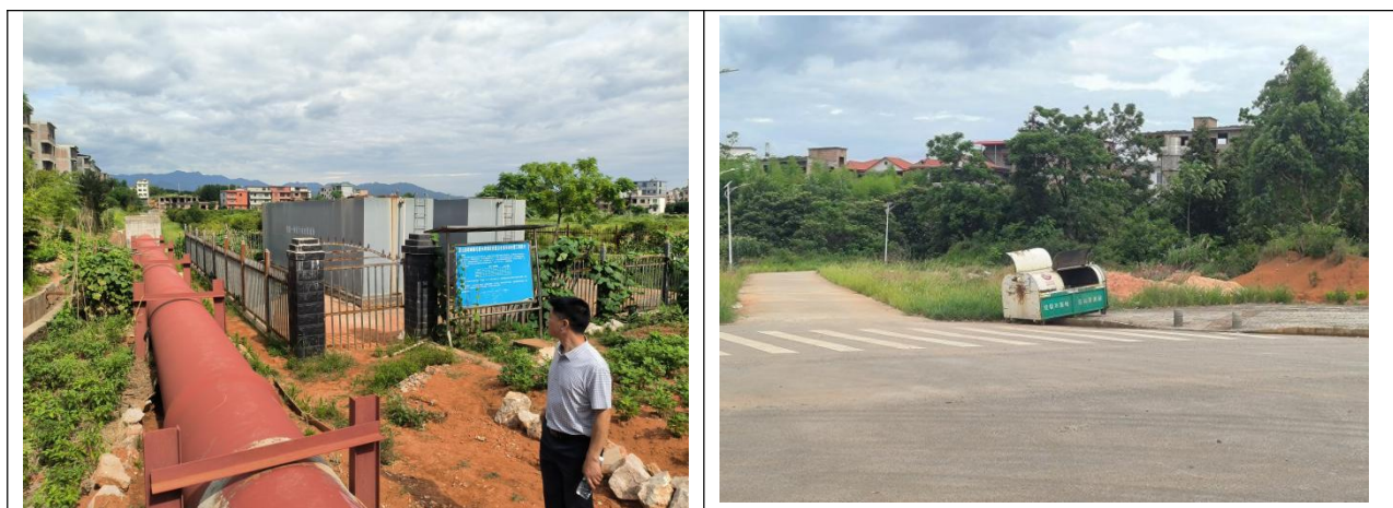
图 5.7-2 移民安置区污水处理设备和垃圾收集桶
