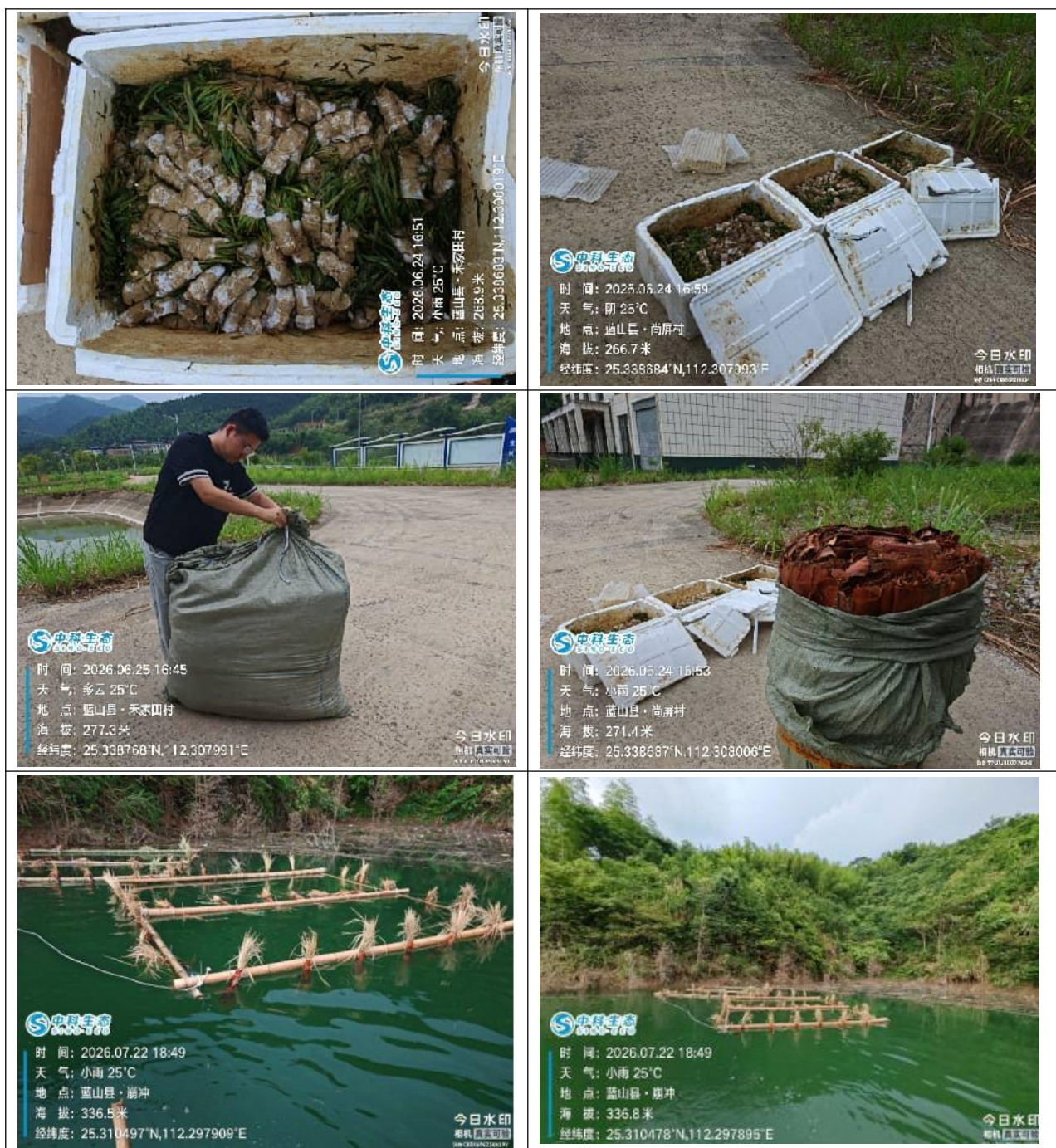
图 4.2-4 河道生境修复现场材料准备及工程实施
