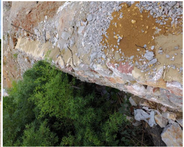
照片4 矿山挡土墙
