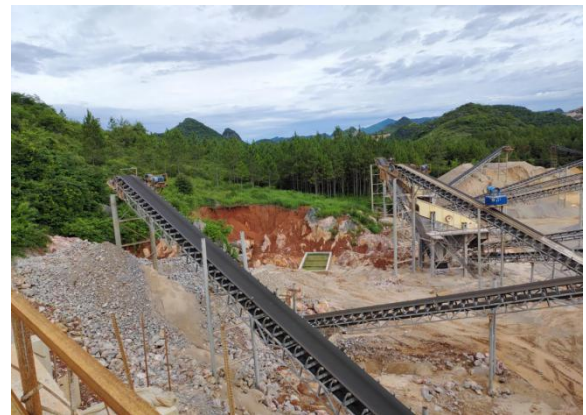
照片6 矿山沉淀池
